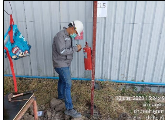
ภาพที่ 22 เจ้าหน้าที่ตรวจสอบถังดับเพลิง
